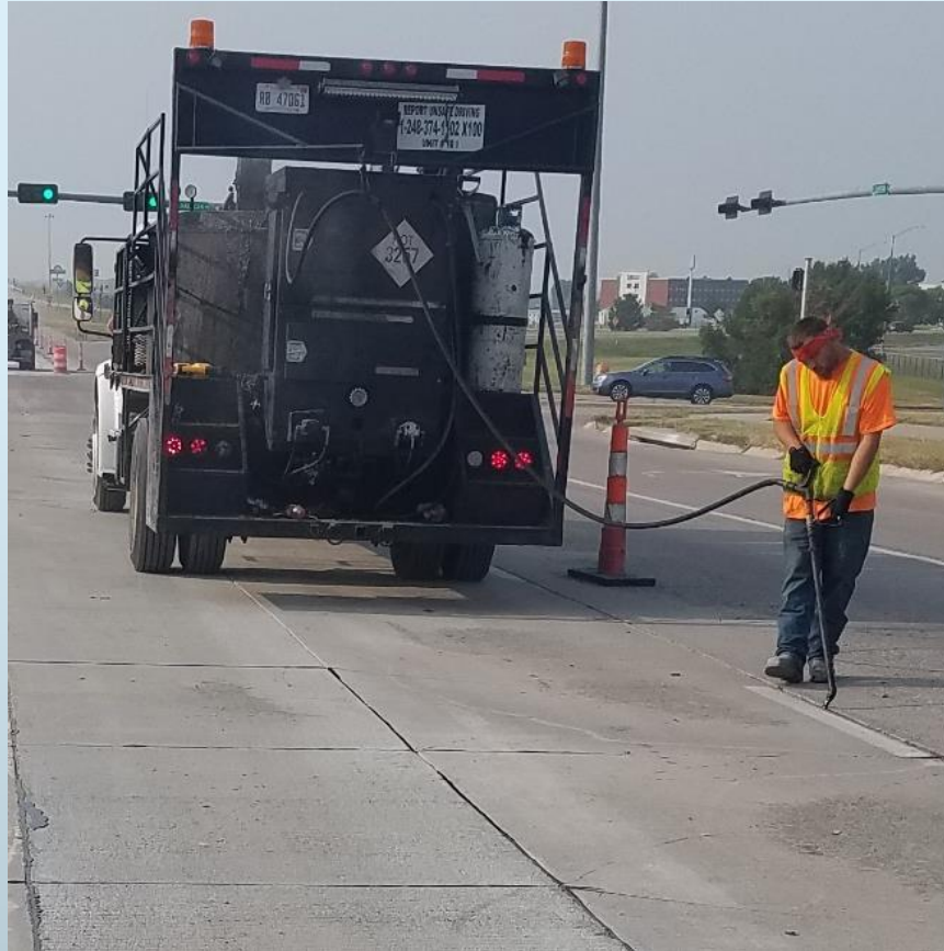
Hot Pour Sealing Joints
