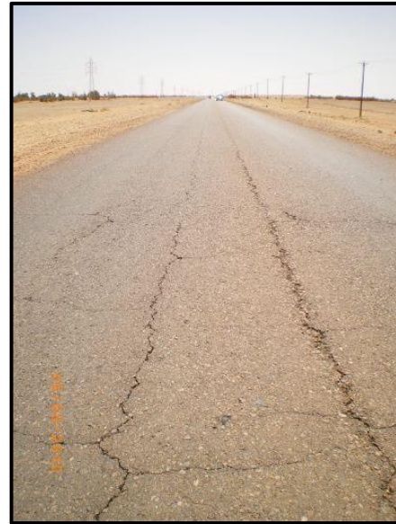
Longitudinal Cracking
