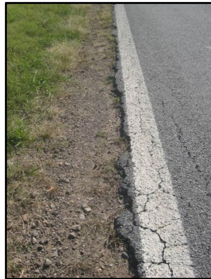
Edge Cracking
