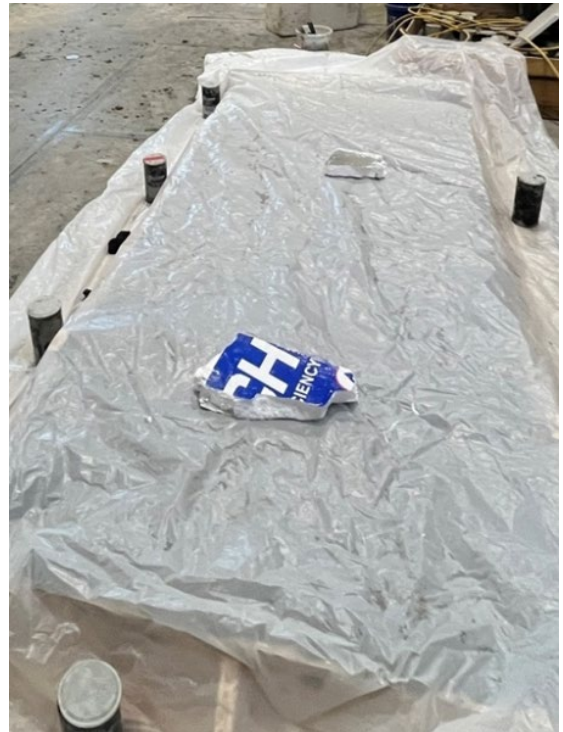
(d) Plastic Sheet Covering for Curing
